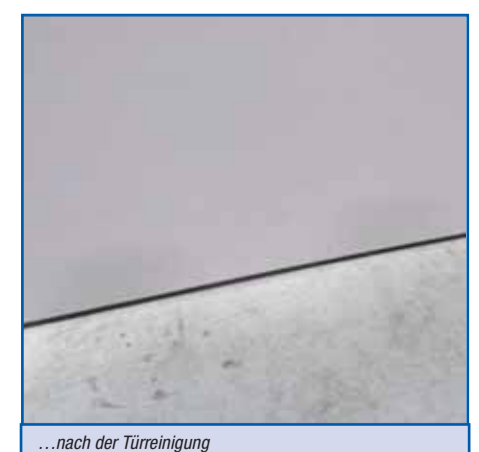
...nach der Türreinigung
