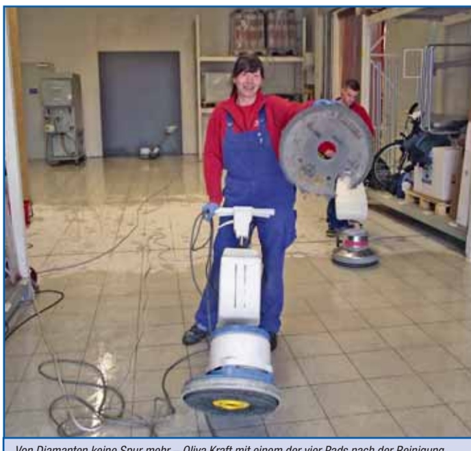
Von Diamanten keine Spur mehr – Oliva Kraft mit einem der vier Pads nach der Reinigung.
